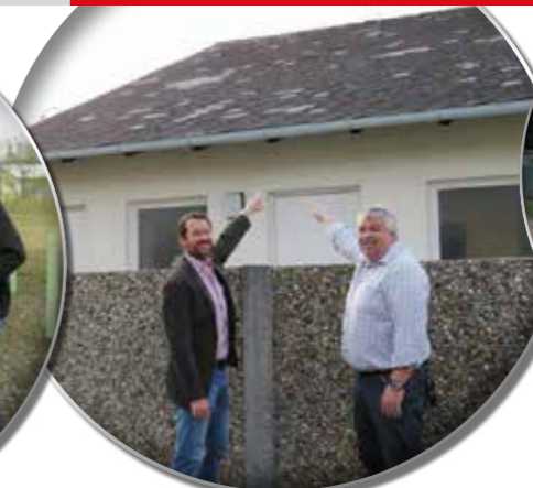
NEUES DACH FÜR DIE AUFBAHRUNGSHALLE bis Sommer 2019
